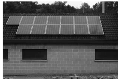
Les panneaux photovoltaïques à la JSI
